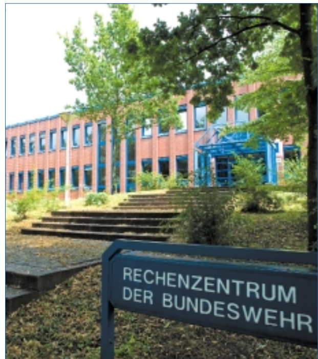
Konsolidierungs-Rechenzentrum für Zentrale Dienste
