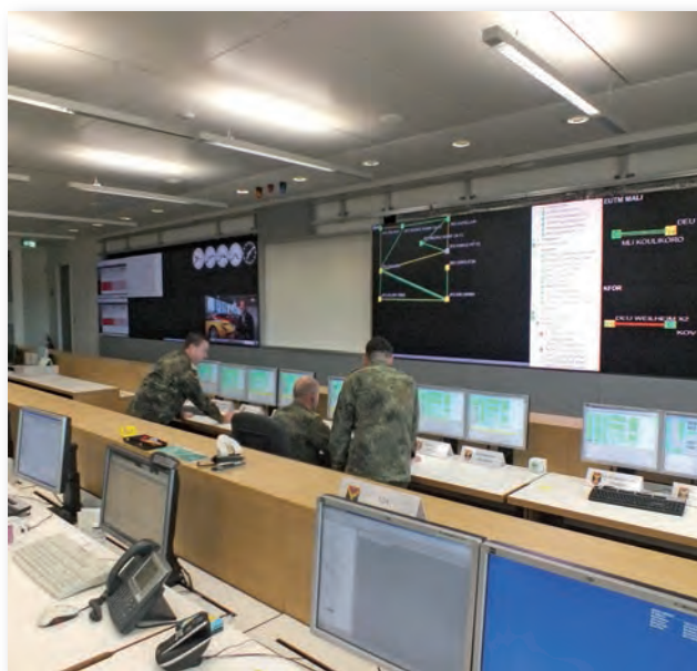
Steuerung und Überwachung des IT-SysBw durch das Network Operations Center Basis Inland.
