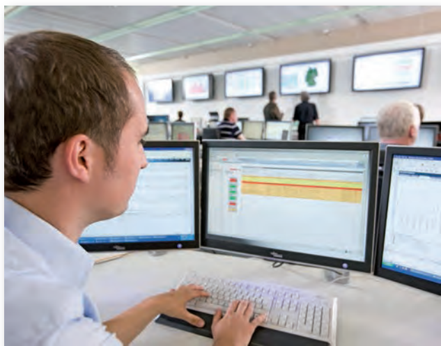
Das Monitor- und Control-Center der BWI ermöglicht ein zentrales Management der Rechenzentren.
