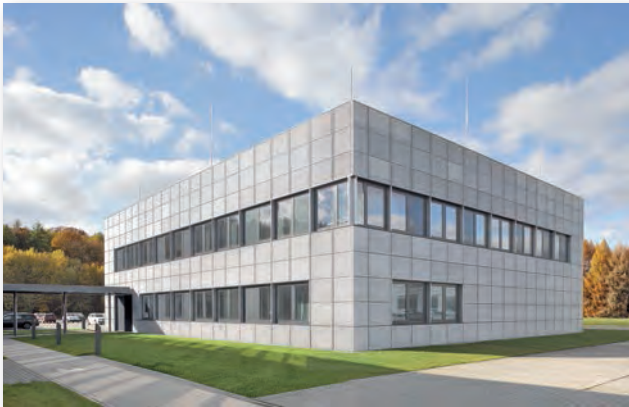
Betriebskompetenzzentrum BWI und Network Operation Center Basis Inland in Rheinbach arbeiten Tür an Tür.
