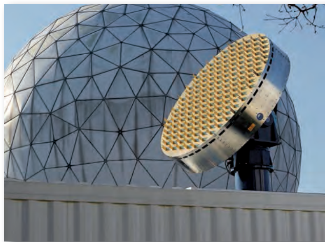
Fraunhofer FHR Weltraumbeobachtungsradar TIRA und von FHR entwickeltes Empfangssystem des ESA Space Surveillance Demonstrators
