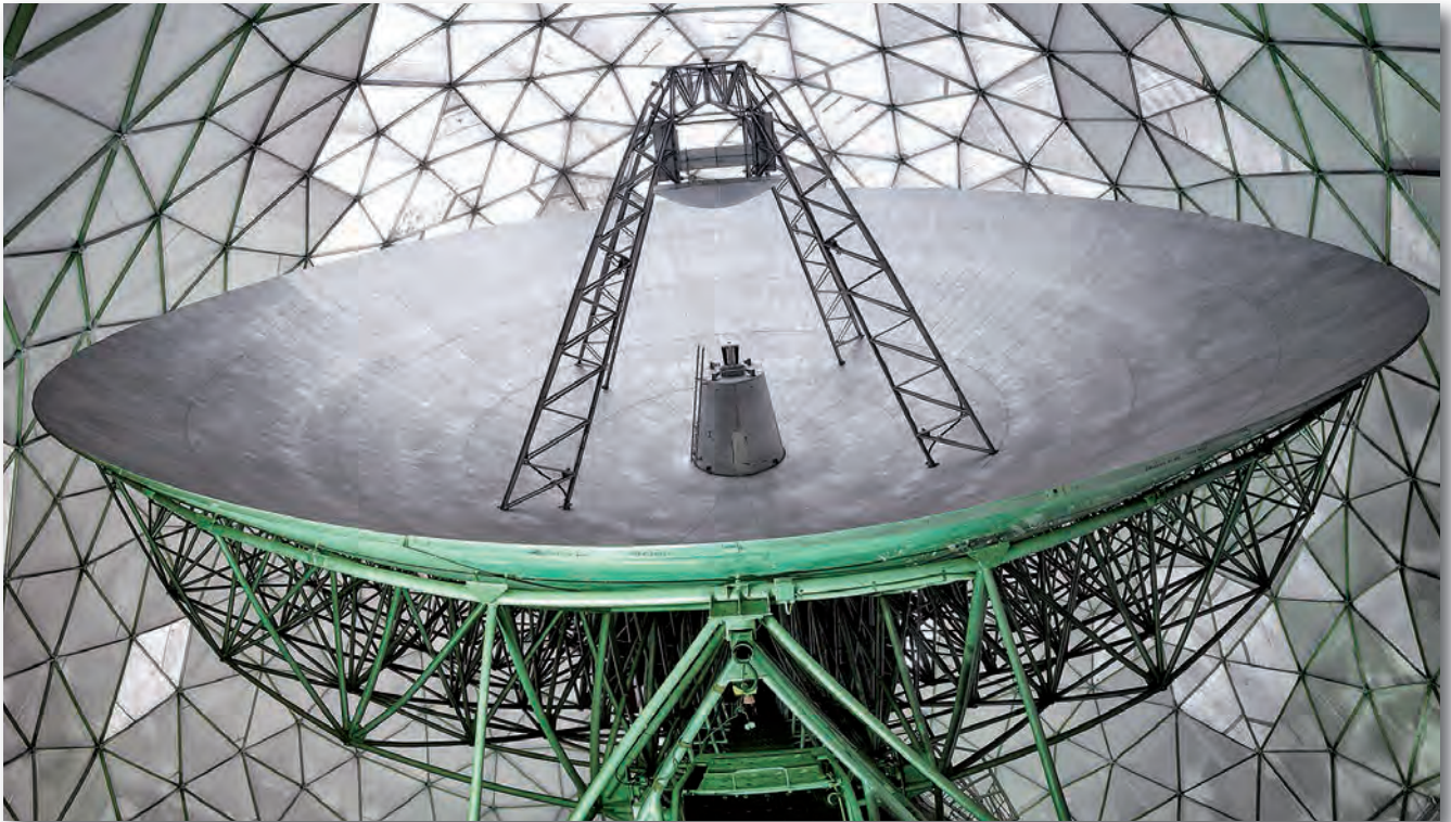
Der Parabolspiegel des Weltraumbeobachtungsradar TIRA im Innern des Radoms
