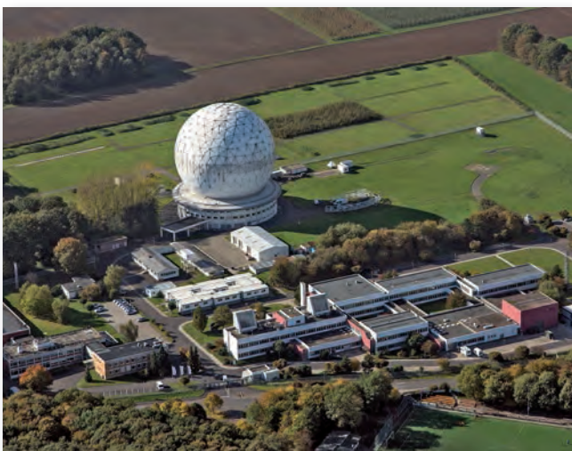
Institutsgelände des Fraunhofer FHR in Wachtberg.
