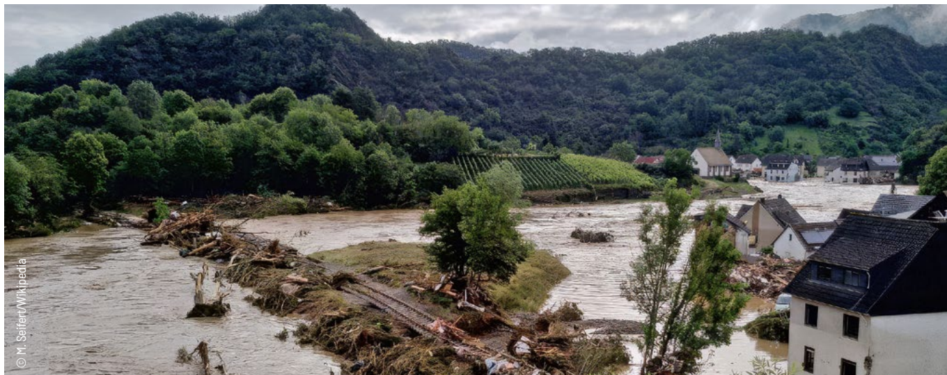
Hochwasser in Altenahr-Altenburg am 15. Juli 2021
